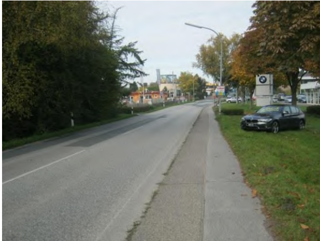
Bild 59 Lübecker Landstraße (L 57), einwärts in Höhe QS LL1 H&P
