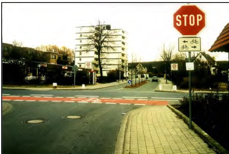
Bild 4: Sicherheitserhöhende Kennzeichnung einer Radwegfurt mit Zweirichtungsbetrieb
